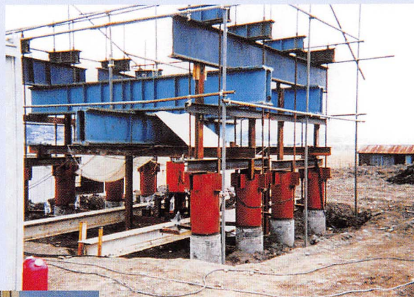
載荷試験装置
