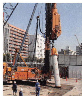
杭吊り装置(下杭)
