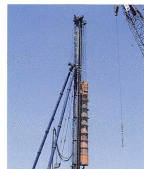
テレスコ型飛散防止装置
