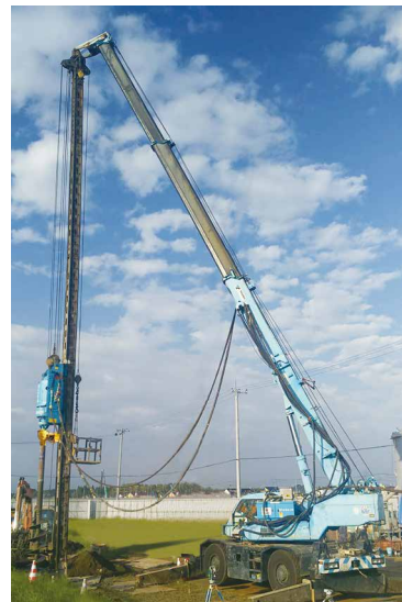
ラフター型杭打機
