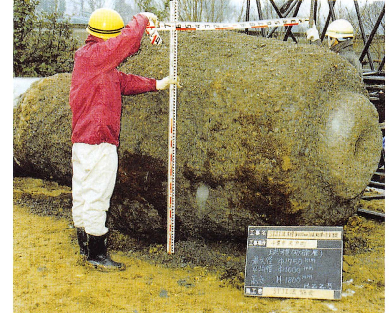
▼杭径1,000mmの球根築造掘出し状況
